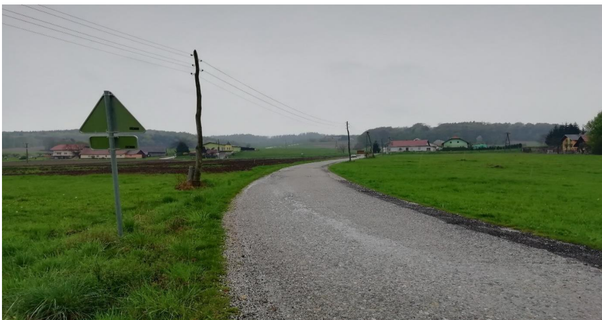
Slika 6: Lokalna cesta LC060-063 Strmec- Jiršovci
